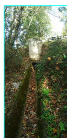
CANALE DI SCOLO
