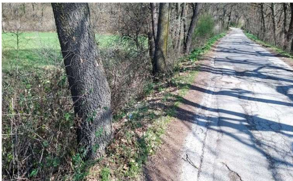
Foto 6. Tratto di carreggiata realizzata su rilevato artificiale in prossimità del Fiume Sagittario.
