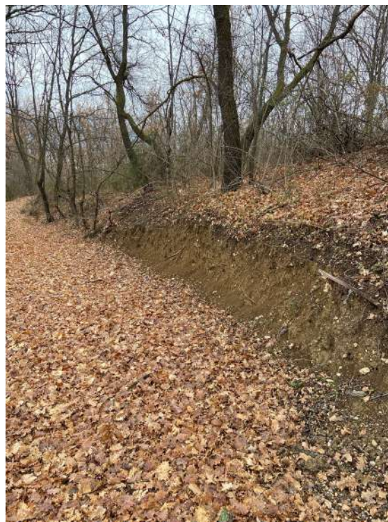
Foto 3. La parete di scavo, eseguita in prossimità della strada comunale di Santa Brigida, mette in luce la natura dei terreni che compongono la coltre colluviale.
