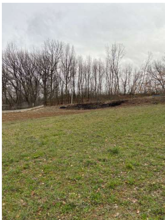
Foto 4. Area interessata dai fenomeni di soliflusso. Sullo sfondo la strada comunale interessata dal progetto di messa in sicurezza.
