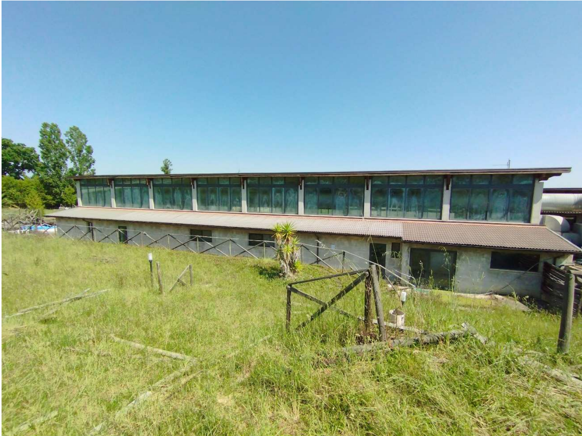
Foto n.5 – Vista prospetto sud.
