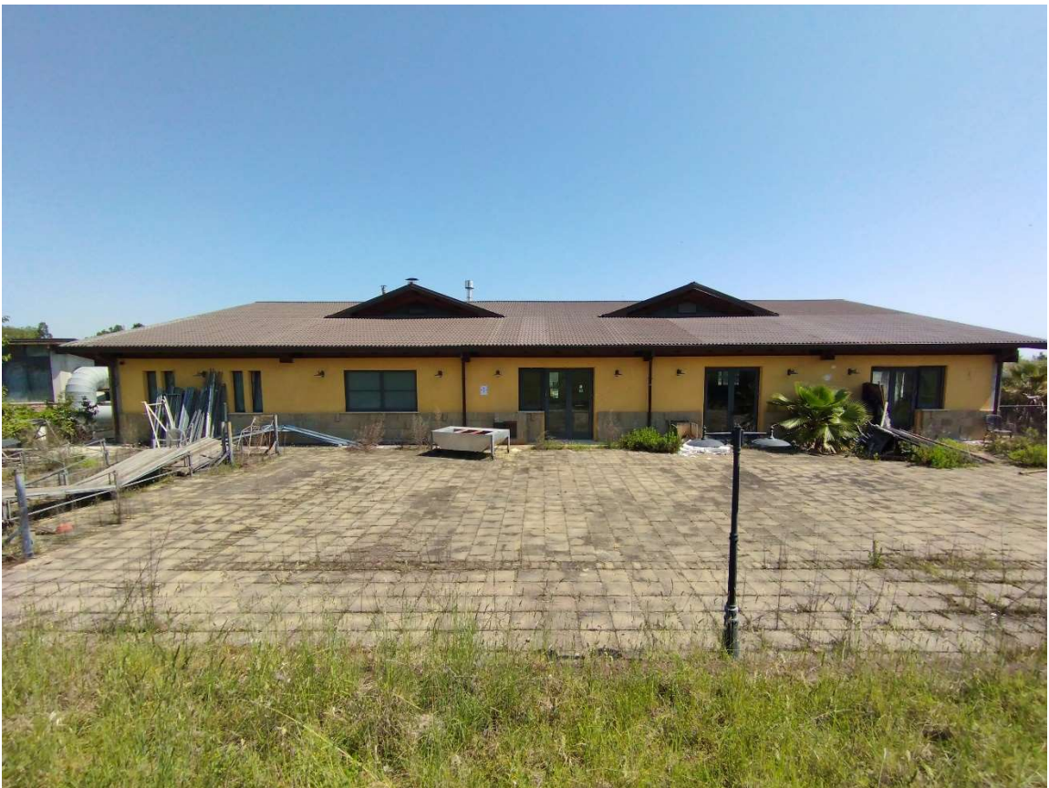
Foto n.4 – Vista prospetto sud.
