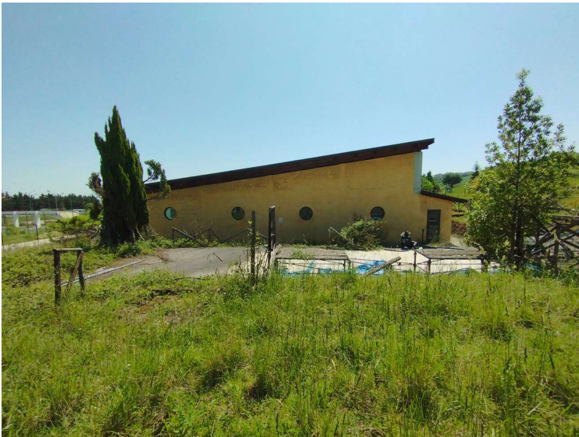
Foto n.6 – Vista prospetto ovest.
