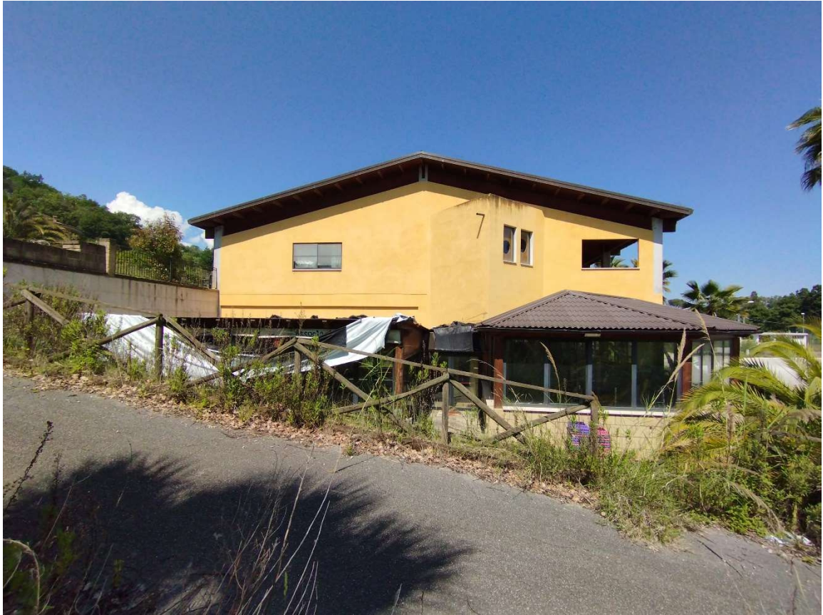
Foto n.3 – Vista prospetto est.
