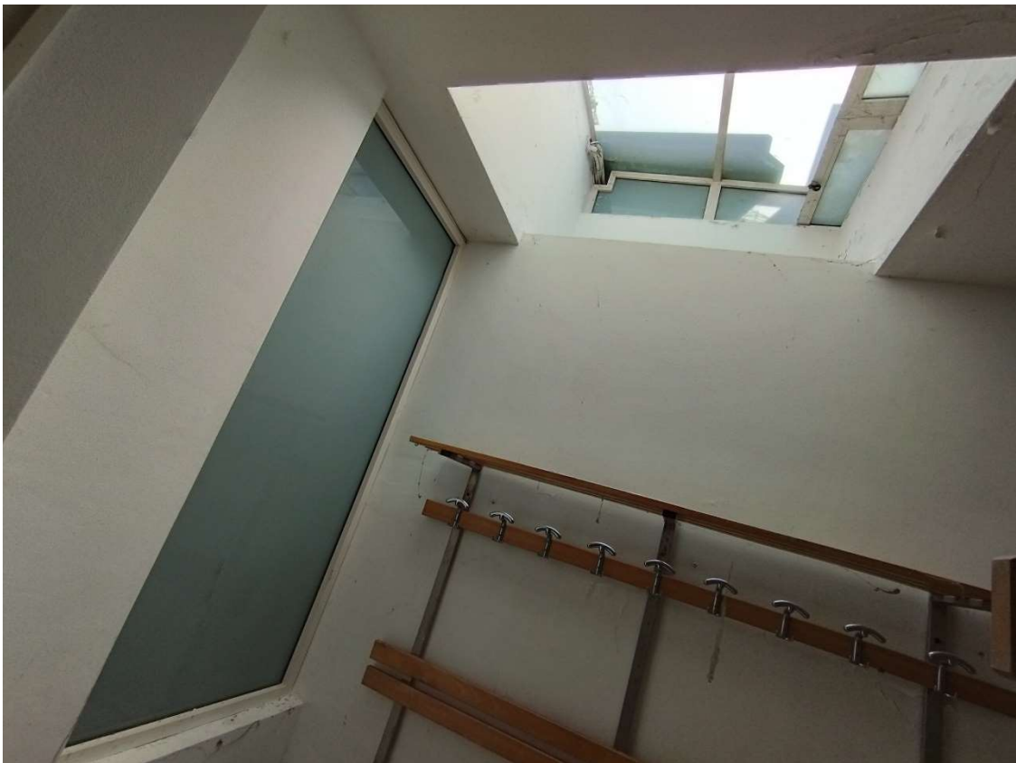
Foto n.8 – Vista interna lucernaio esistente.
