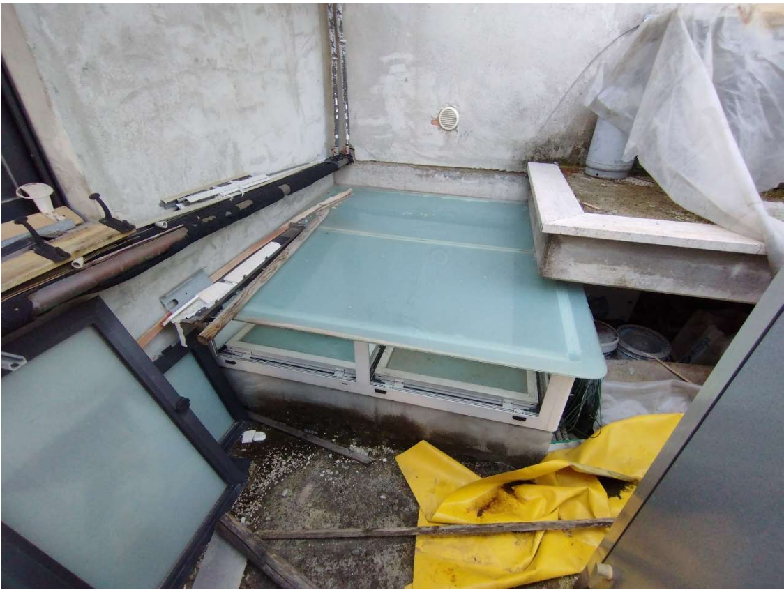
Foto n.7 – Vista esterna lucernaio esistente.
