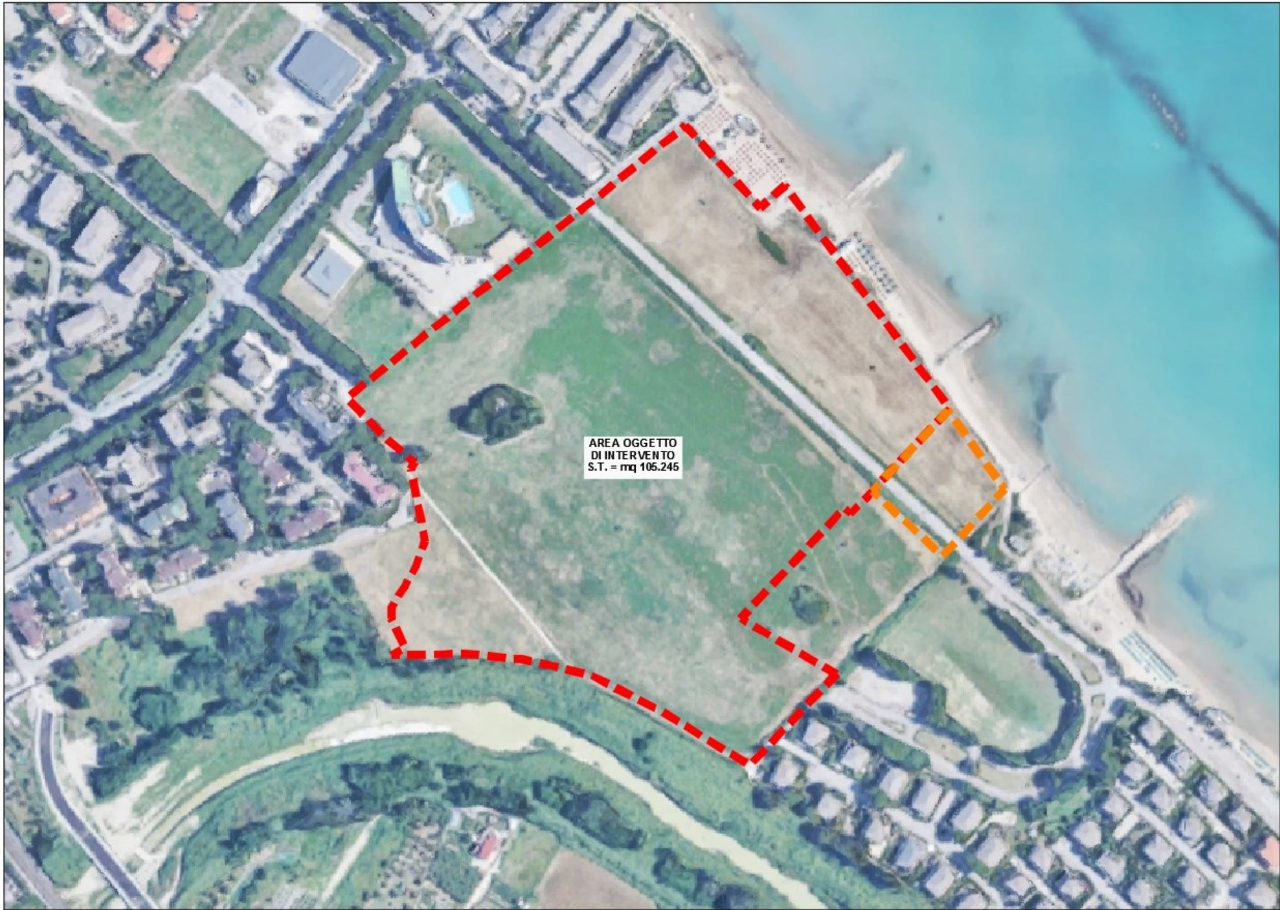
FOTO AEREA: AREA DI INTERVENTO
