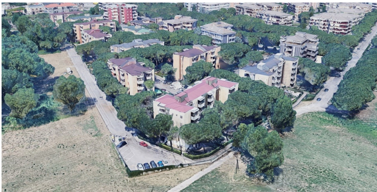
Assetto urbano esistente lungo Viale Reno e Via Saline
