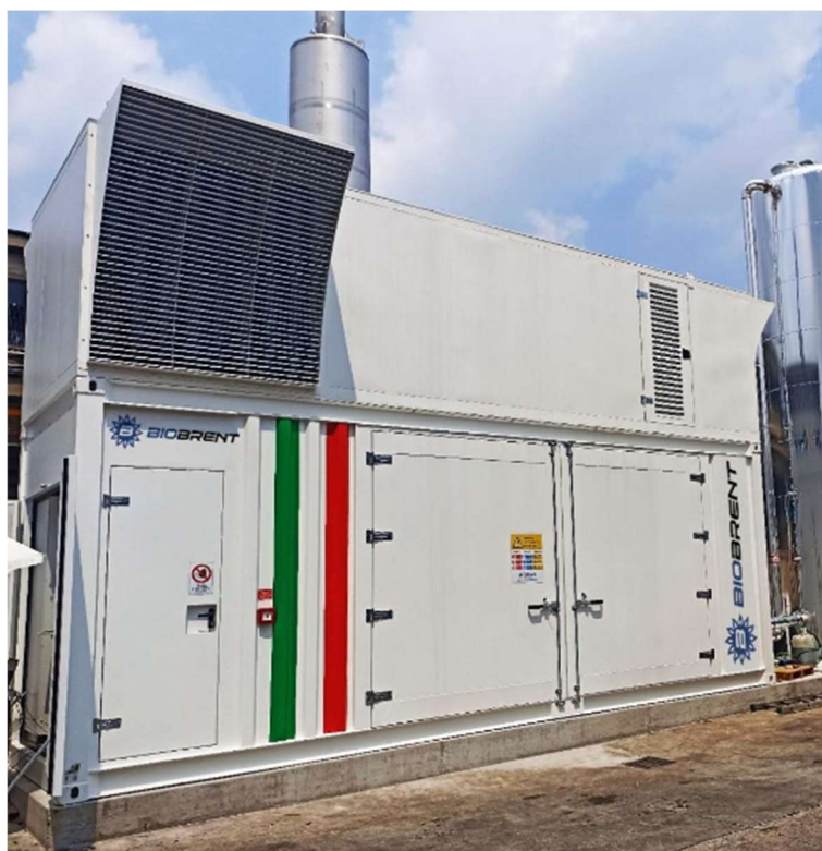
Figura 36 – Cogeneratore di energia elettrica ed acqua calda 97
