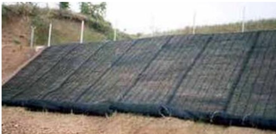
Bobine di geostouia poste in opera su un versante stradale
