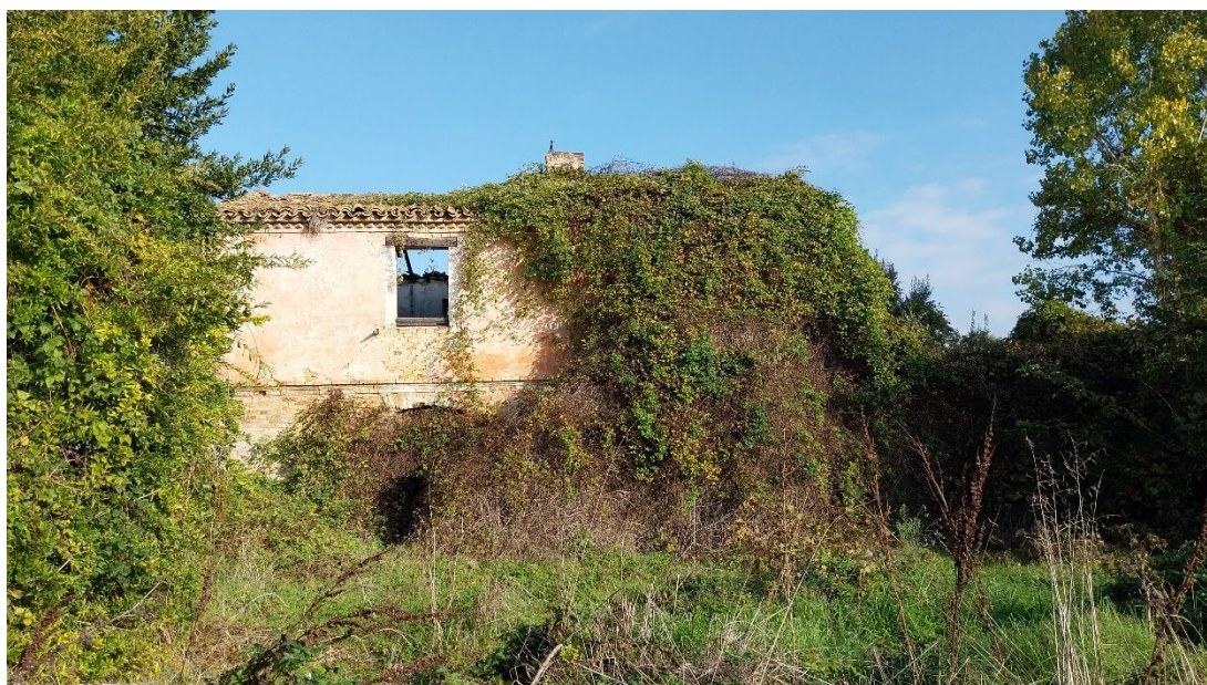
Figura 80 – Fabbricato di categoria A presente a Nord-Ovest dell'area di impianto
