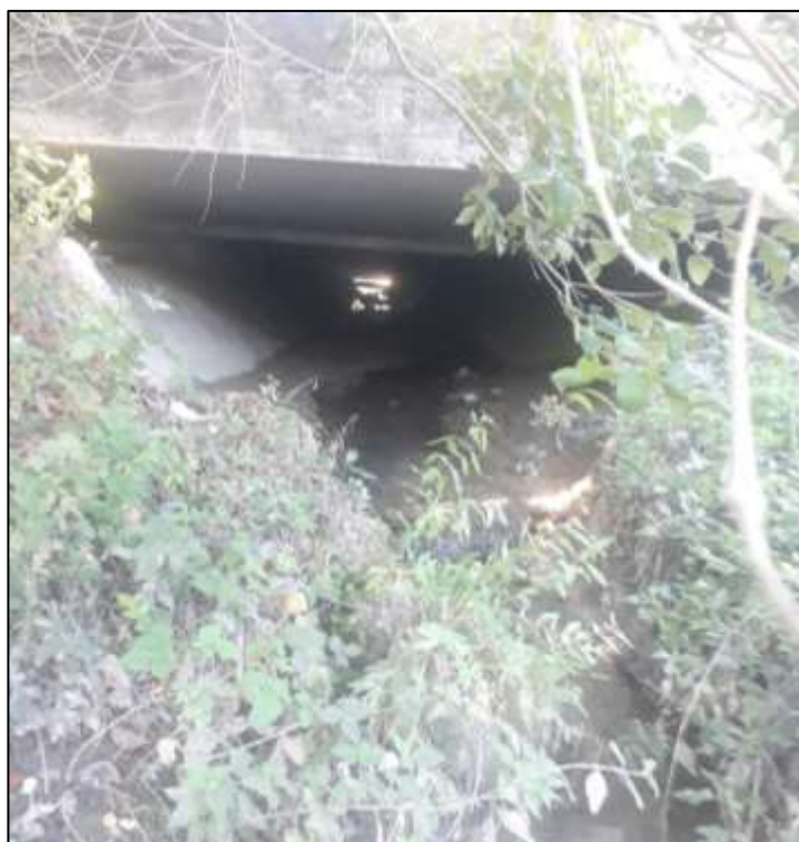
4-4 – Scatolare sotto via Arno che si innesta nel fosso oggetto d'intervento, è visibile come nell'alveo ci sia vegetazione infestante e materiale eroso accumulato.
