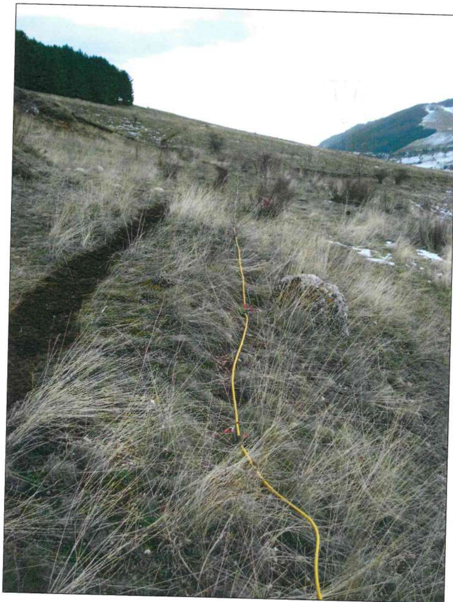
Figura 1: stendimento cavi della linea LN1
