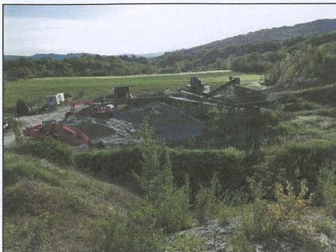
9. Impianto di frantumazione Romani Giacomo
