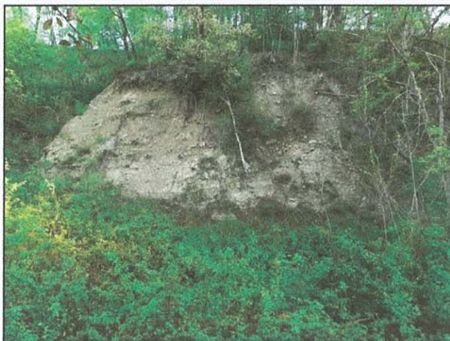
5. Scarpata della strada privata lato fosso Grande
