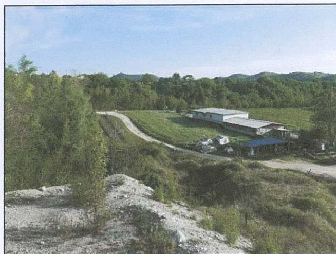
9. Strada d'accesso proprietà Romani Giacomo con particolare della rimessa attrezzi realizzata
