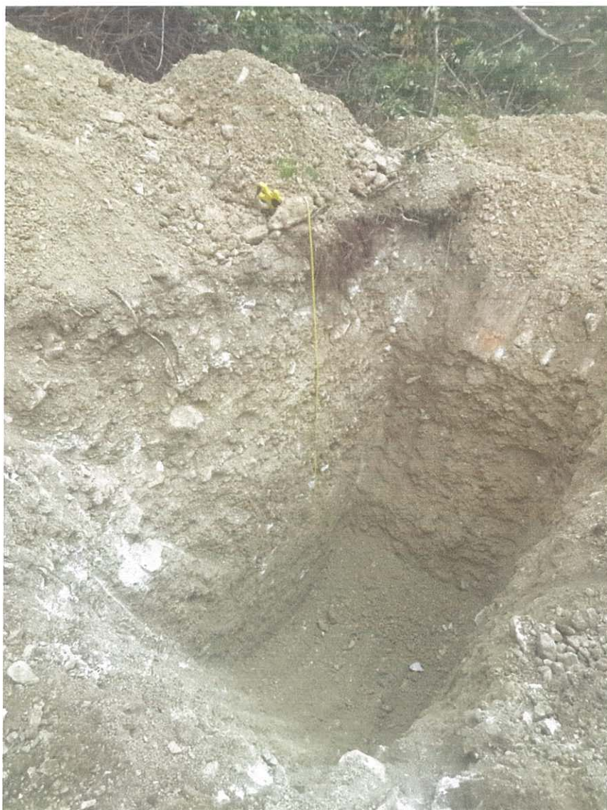
foto n° 3 Piano di scavo finale (Sondaggio realizzato a – 5,00) (non si nota la presenza dell'acqua)
