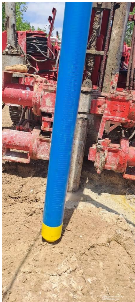
Particolare fase di installazione piezometro
