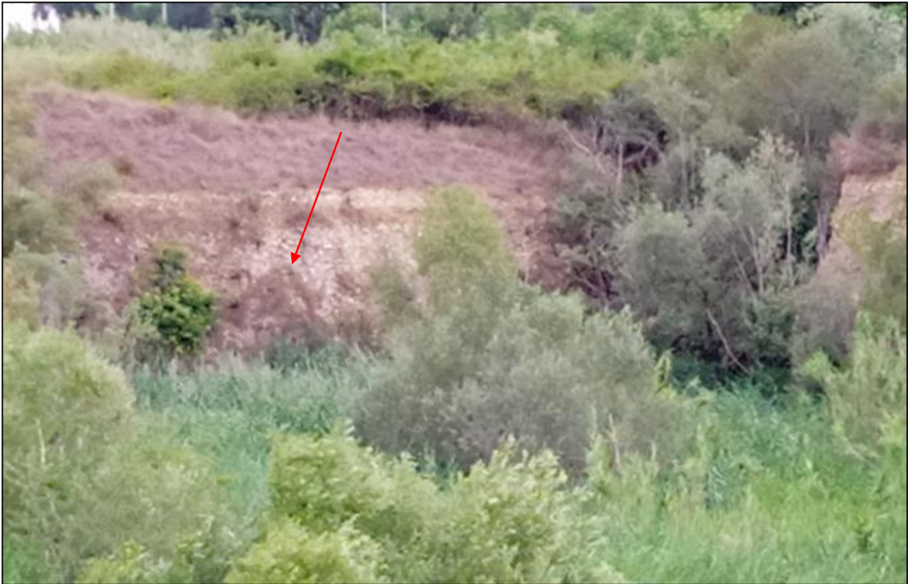
Foto 6 - Vista del fronte di scavo nord occidentale, si riconosce un accumulo detritico al piede della parete subverticale (freccia).
