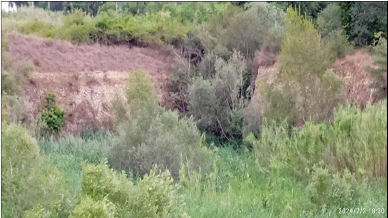
Foto 4 - Stato attuale dei fronti di scavo.
