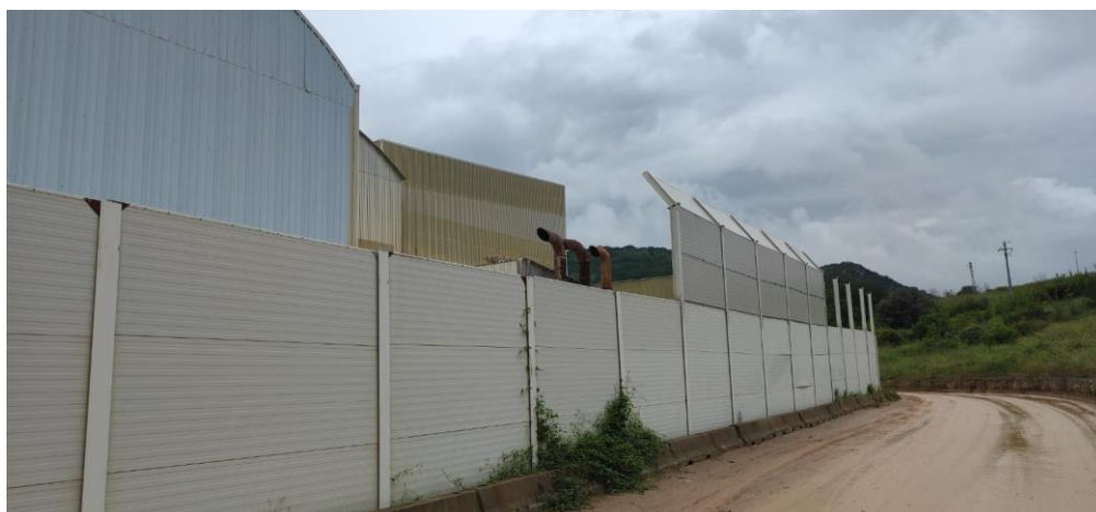
Figura 1 Barriera acustica fonoassorbente e fonoisolante in costruzione presso Granito Forte S.p.a., sito in Zona Industriale 7, Fresagrandinaria (CH)
