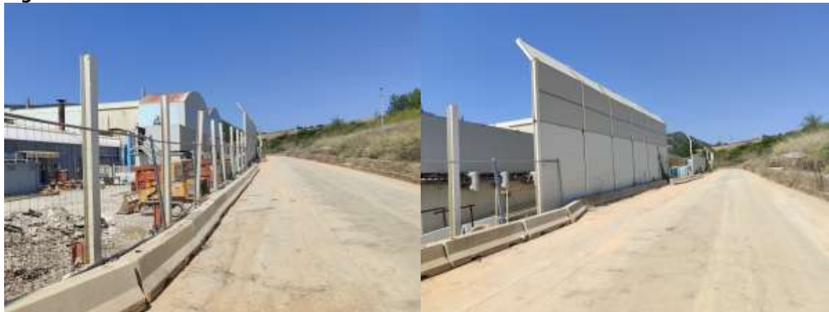
Figura 4.1.4.: barriera acustica a confine
