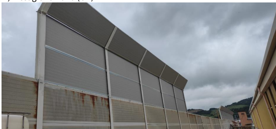
Figura 2 Barriera acustica fonoassorbente e fonoisolante in costruzione presso Granito Forte S.p.a., sito in Zona Industriale 7, Fresagrandinaria (CH)
