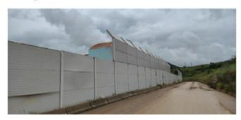
Il tecnico afferma che la struttura in costruzione permette di assorbire il rumore prodotto dall'impianto e presenta caratteristiche fonoisolanti e fonoassorbenti, riportate nel "Manuale tecnico della barriera acustica", allegato alle Relazione Tecnica suddetta.
