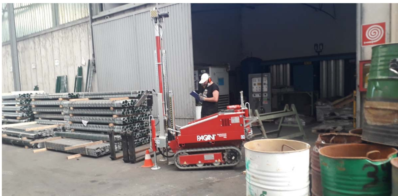
Figura 5 - Ubicazione della prova penetrometrica dinamica super pesante (DPSH, SCPT) P2
