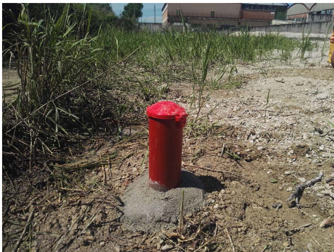
Materializzazione Sondaggio S3
