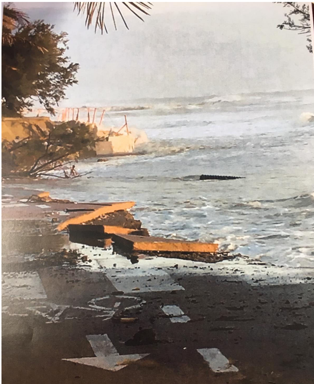
Fig. 2.1-2 Stato del litorale dopo le mareggiate del novembre 2019 – febbraio 2020
