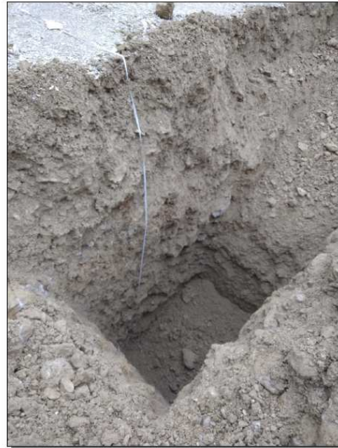
Fondo della trincea realizzata
