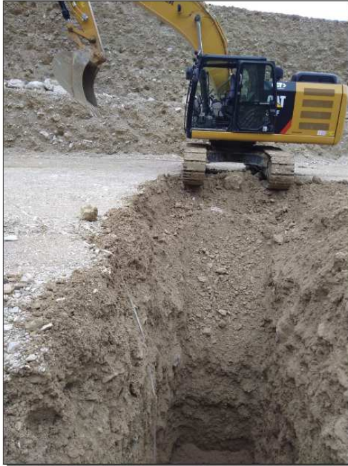
Esecuzione della trincea sul fondo cava attuale
