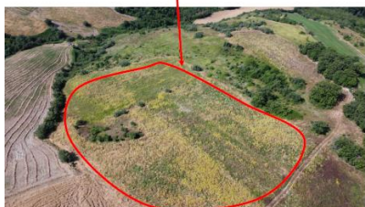
Foto 4: Area di Installazione Moduli
