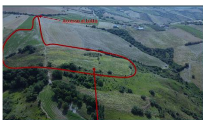
Foto 3: Area di Intervento
