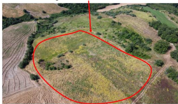
Foto 4: Area di Installazione Moduli
