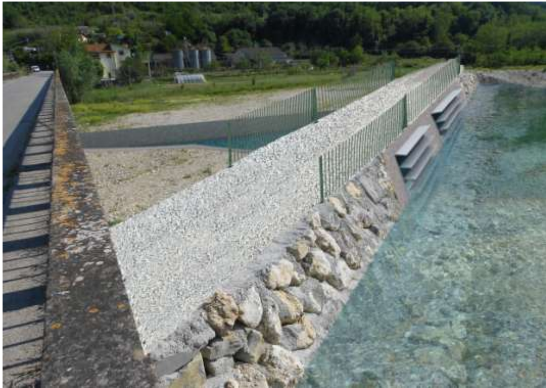
Particolare difesa spondale in DX idrografica con l'inserimento dell'opera di presa da costruire
