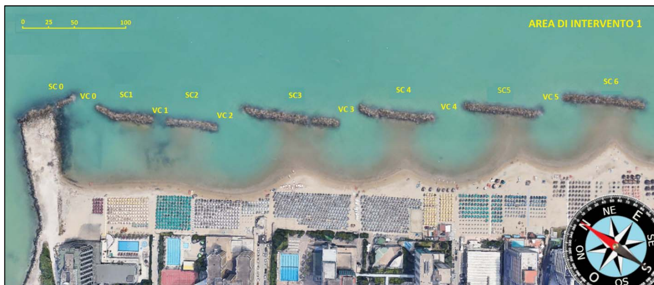
Figura 2 - Area di intervento 1, stato di fatto
