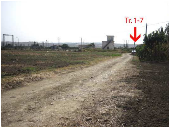
Foto n° 2.1 – S/E di San Salvo, origine del nuovo tratto di Linea
