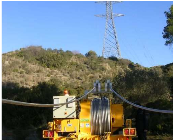
Foto 2.8 - Argano e freno per le fasi di recupero dei conduttori vecchi, di tesatura dei conduttori nuovi.
