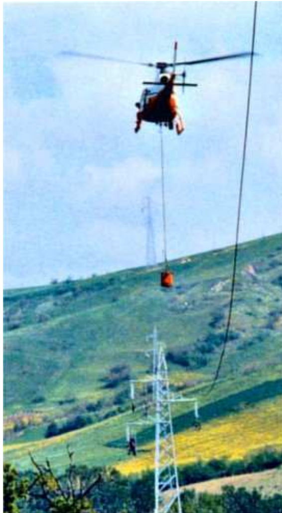
Foto 2.7 - Elicottero nella fase di tesatura della fune di nylon: le maestranze collaborano sui tralicci.
