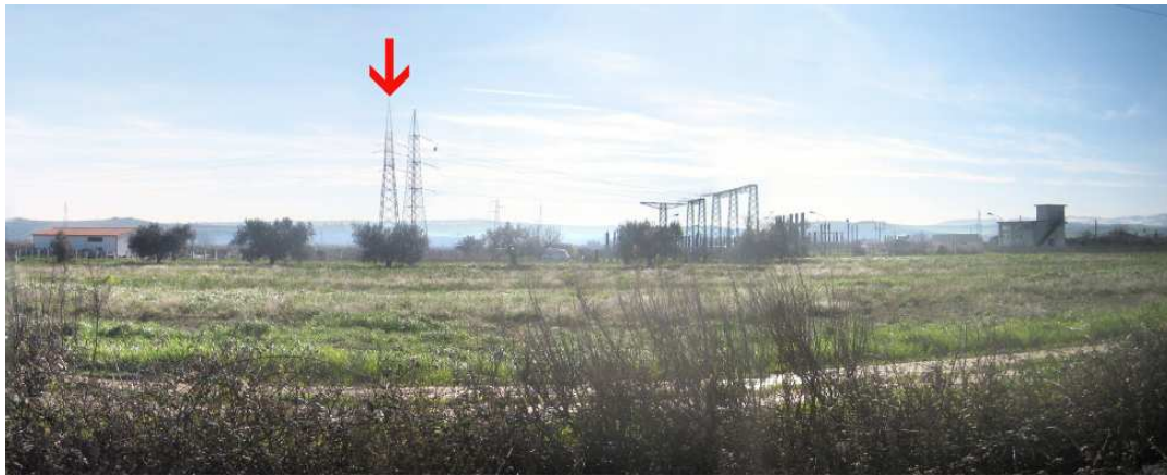
Foto n° 2.4 – Perimetro esterno S/E Enel, origine Linea A.T. 23895
