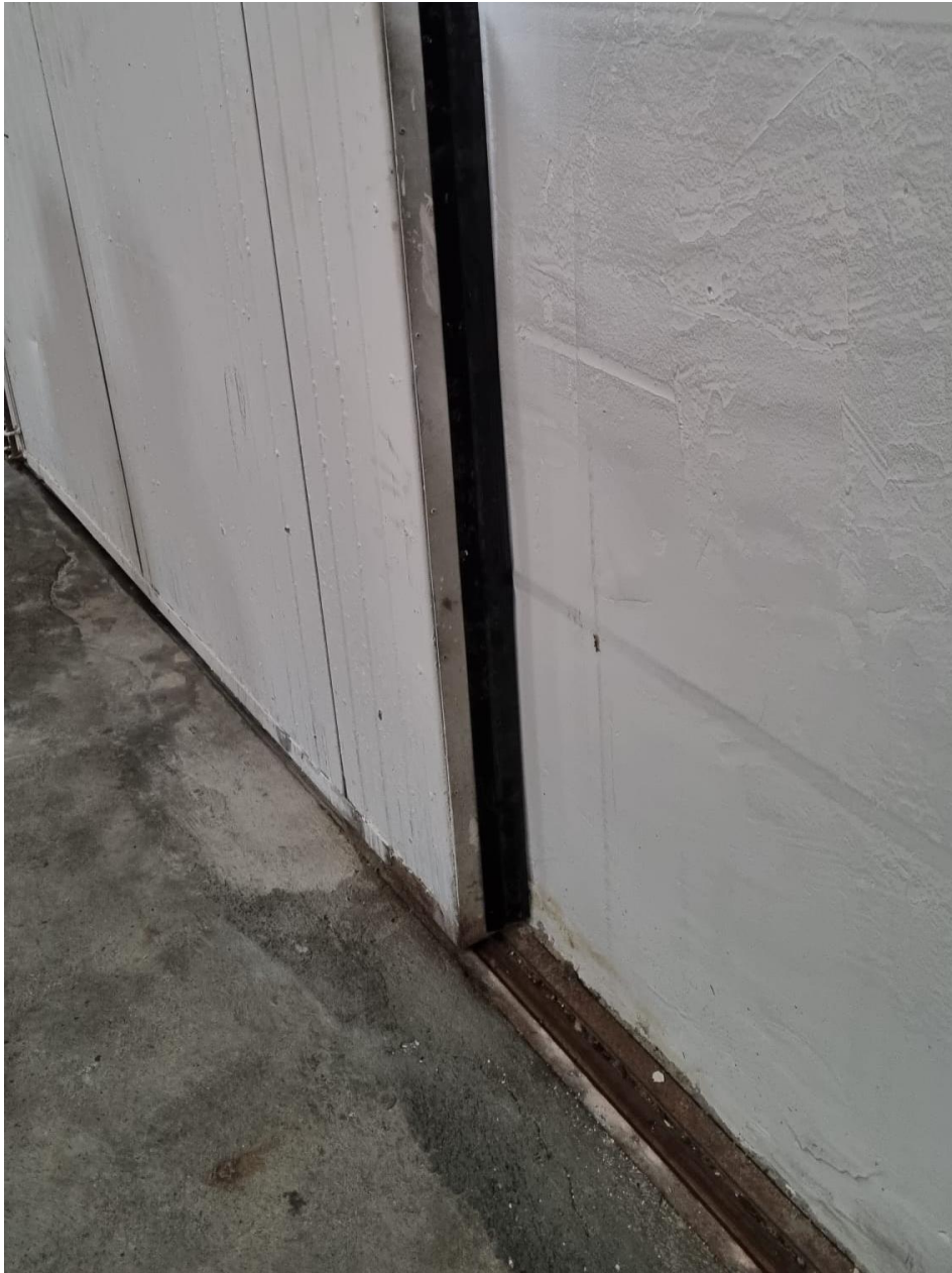
Figure 7 Particolare sistema di chiusura a tenuta stagna – vista dall'interno
