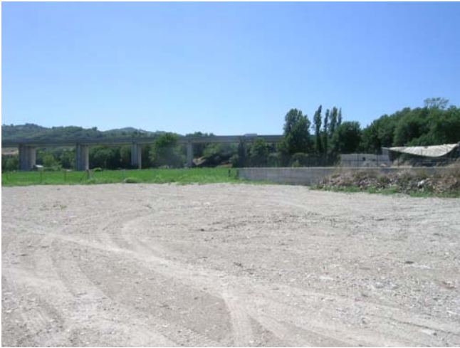
FOTO 3 – VISTA LATO SUD-EST
