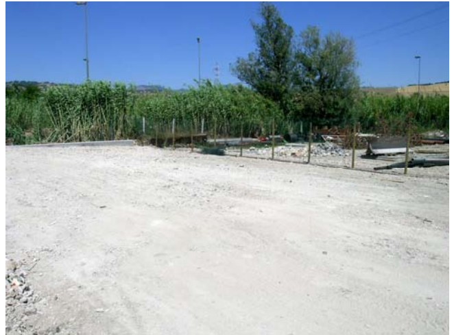
FOTO 4 – VISTA LATO NORD-OVEST
