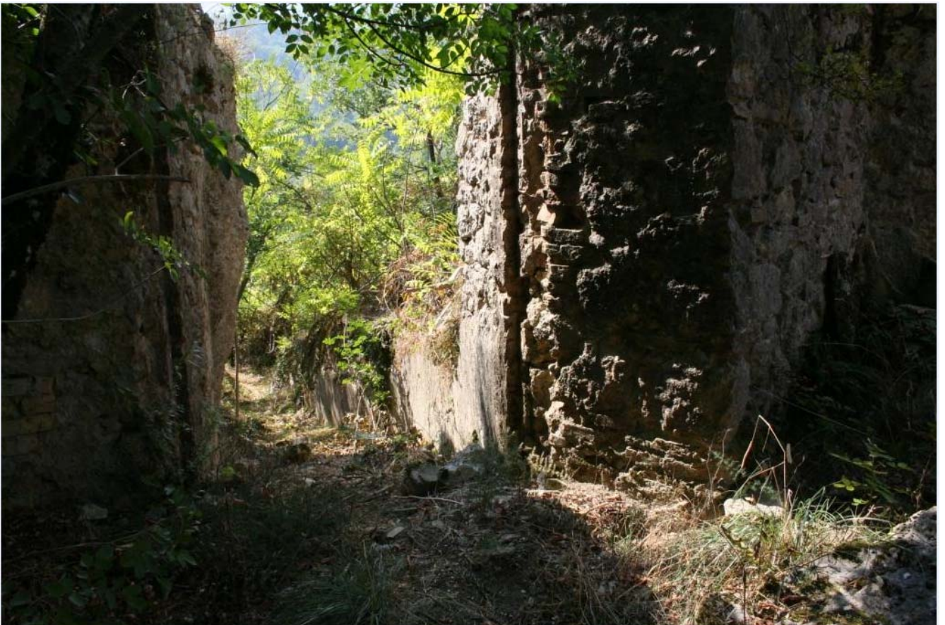
canale di derivazione – imbocco vasca di carico
