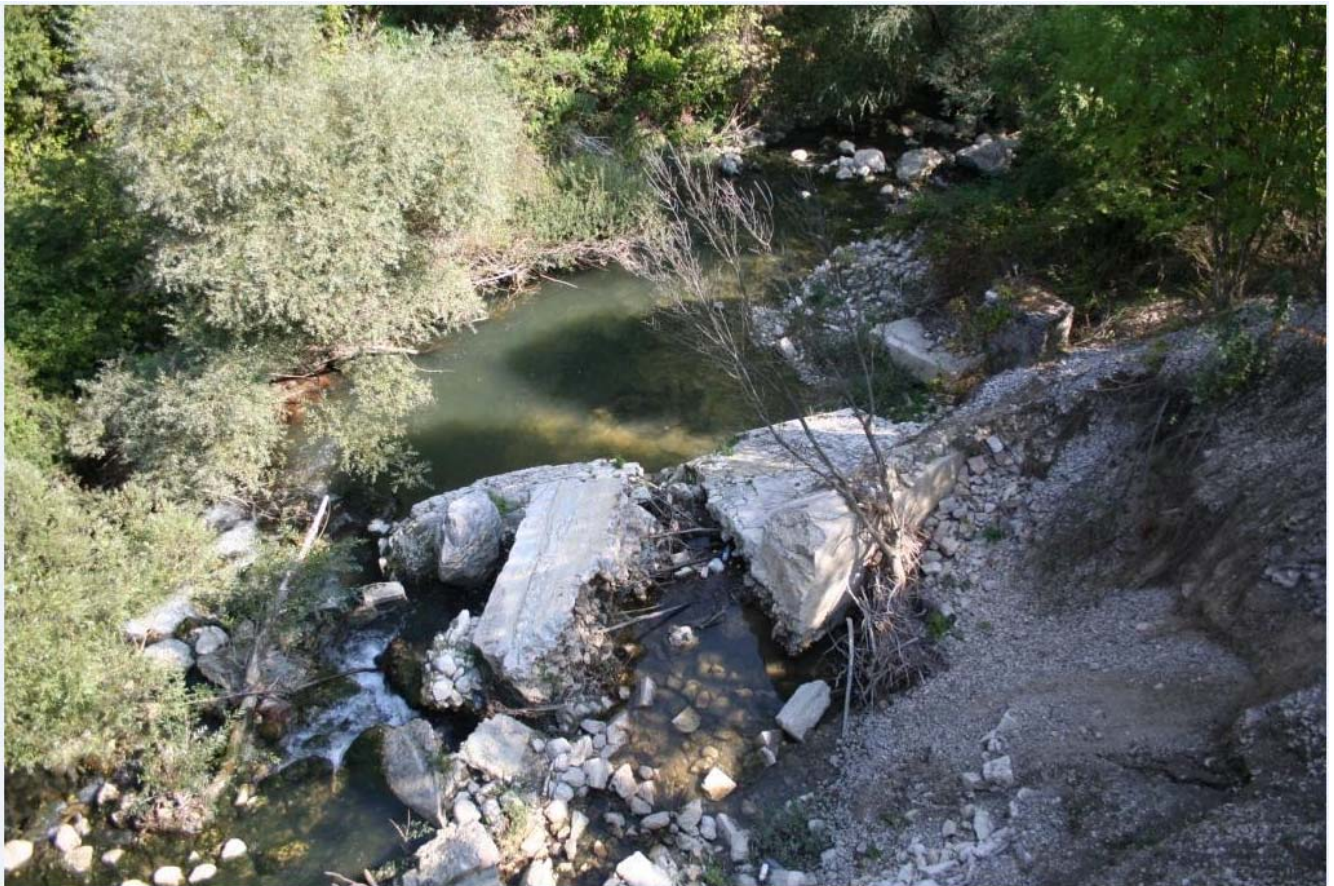
Traversa sul fiume Liri
