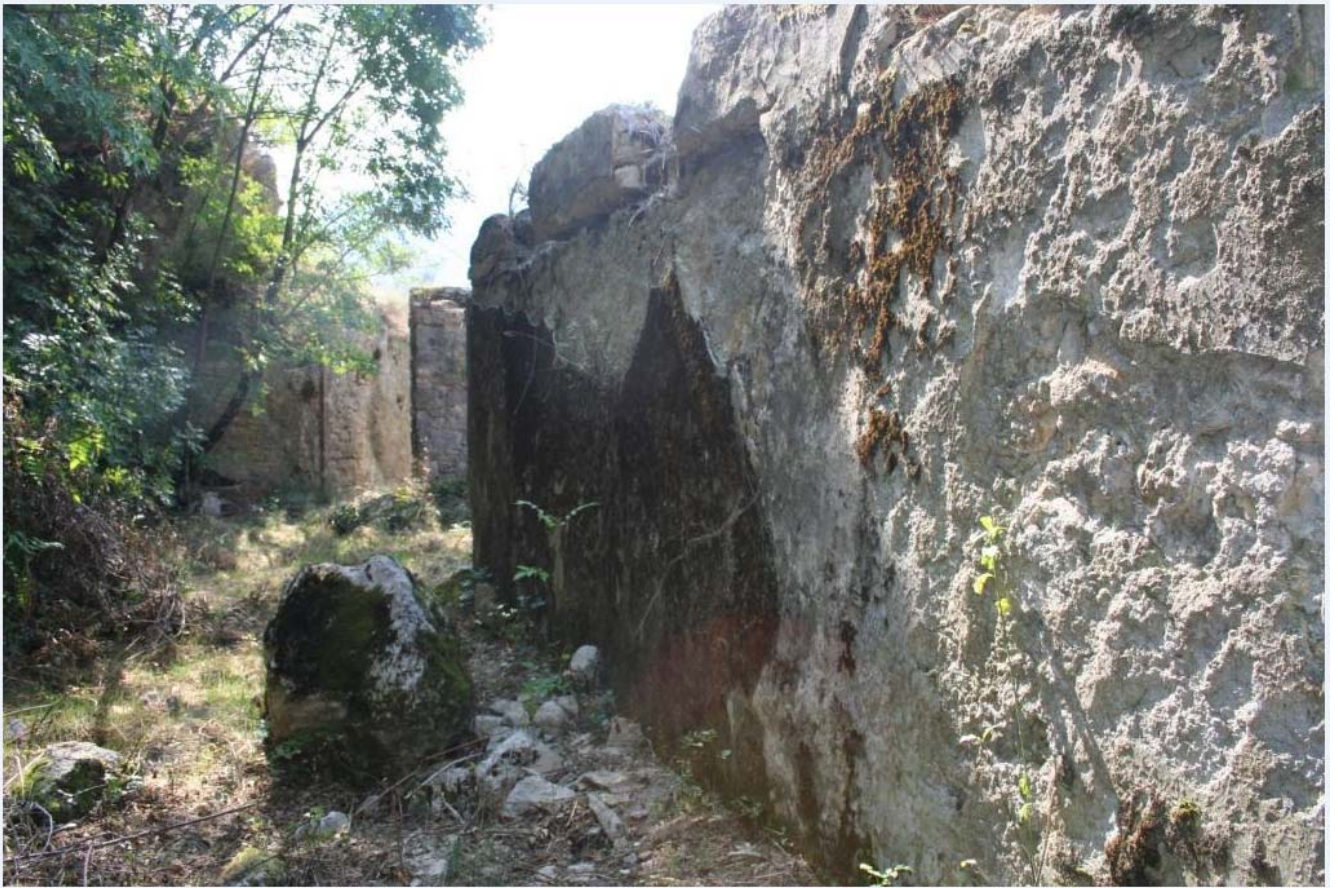
Vasca di carico
