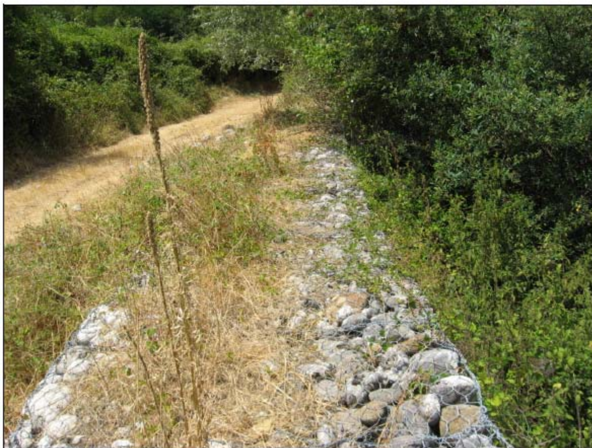
Foto 3.4– Gabbionata lungo la riva del fiume Liri
