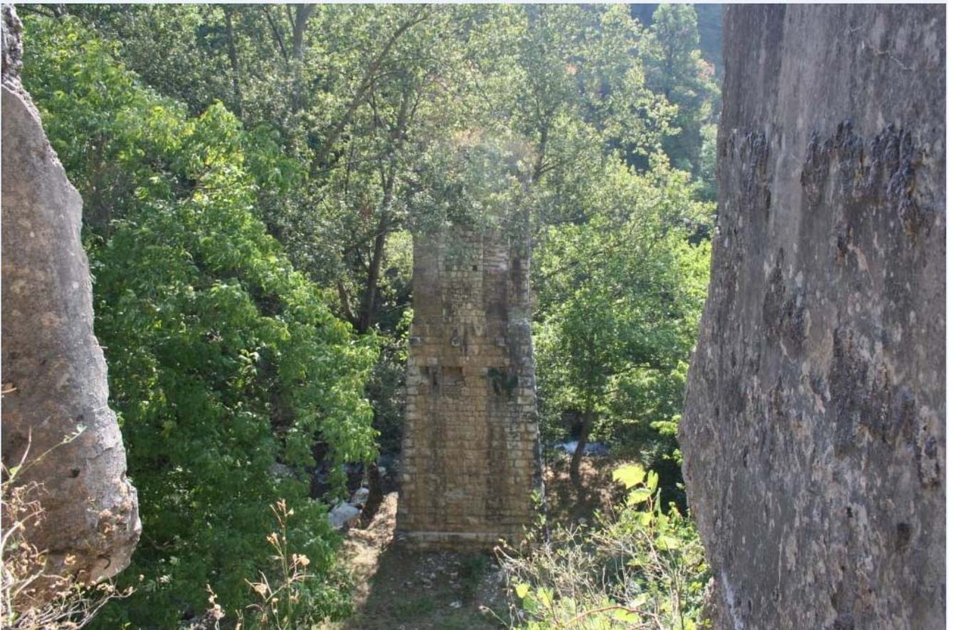
Pilone di sostegno del Ponte Canale
