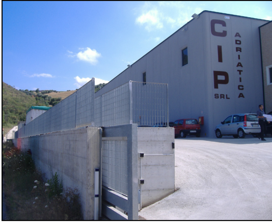
PIATTAFORMA A: particolare cancello d'ingresso e recinzione
