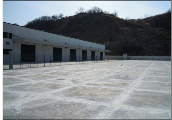
PIATTAFORMA B: Piazzale vista Est
