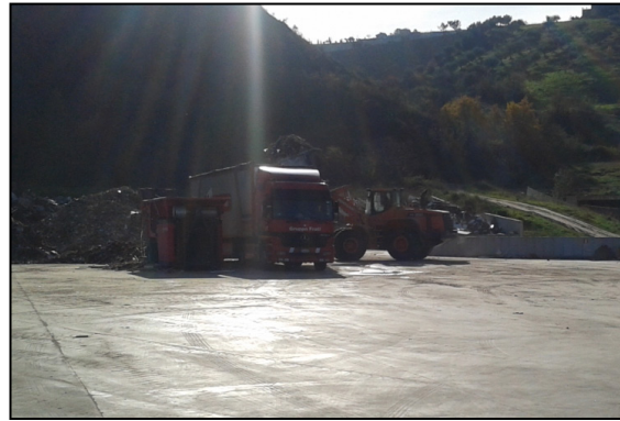
PIATTAFORMA B: Area trattamento
