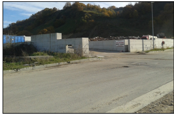
PIATTAFORMA B: Strada accesso al sito
