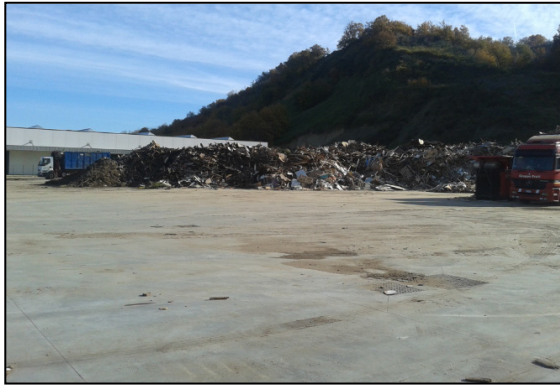
PIATTAFORMA B: Piazzale vista Nord-Est
