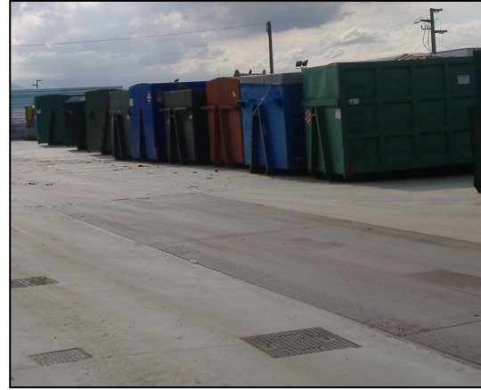
PIATTAFORMA A: particolare della pesa e del Settore 3.a
