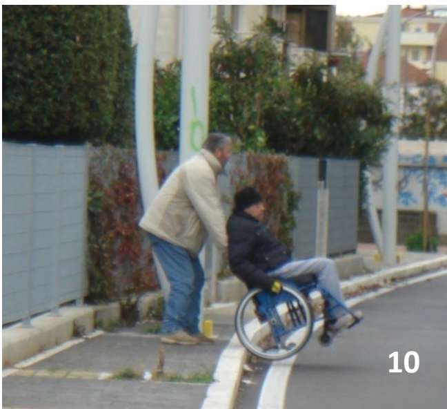
Foto 10 e 11. La persona sulla carrozzina è costretta a scendere dal marciapiede a causa dell'ingombro del palo che gli impedisce di proseguire il suo cammino, deve farsi aiutare da qualcuno perché non c'è traccia di scivolo per tutto il lungo tratto di Viale Europa.
