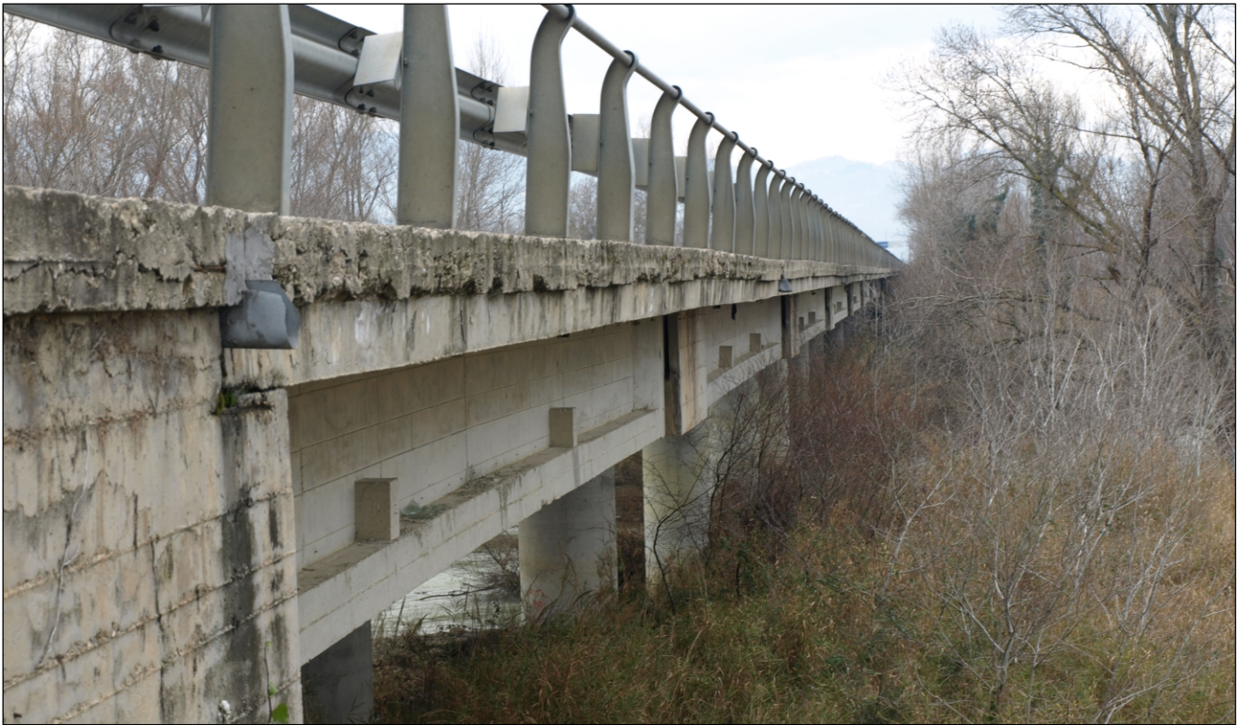
Viadotto su Strada Statale 652
