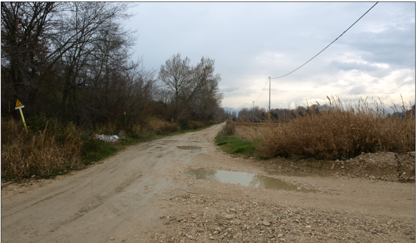
Strada di pertinenza della S.S. 652 (passaggio cavidotto)
