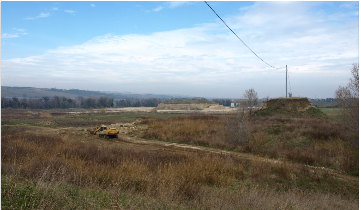
Area di intervento
