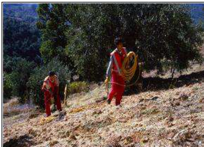
Figura 3.12 - Stesura dei cavi, dei geofoni e della strumentazione
