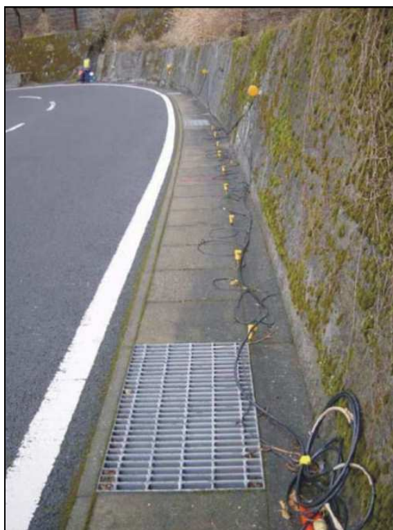
Figura 3.14 - Esempio di stendimento geofoni su strada
