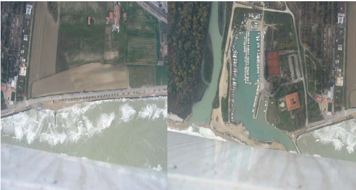
Roseto degli Abruzzi, Zona Sud. Attuazione primo stralcio di lavori (1° e 2° lotto funzionale).
