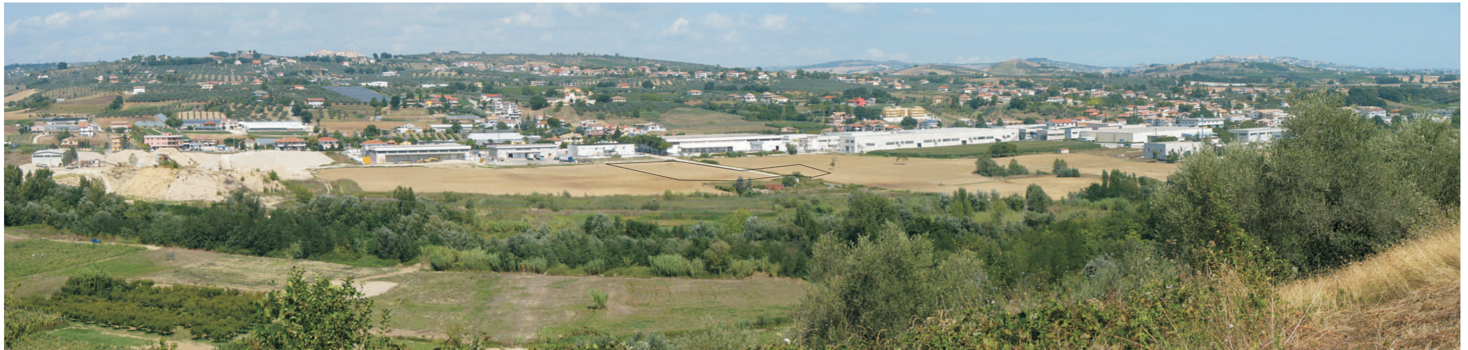
Panoramica dell'area di ampliamento della cava ripresa dalla collina sul lato meridionale della valle. A sinistra l'impianto di destinazione
