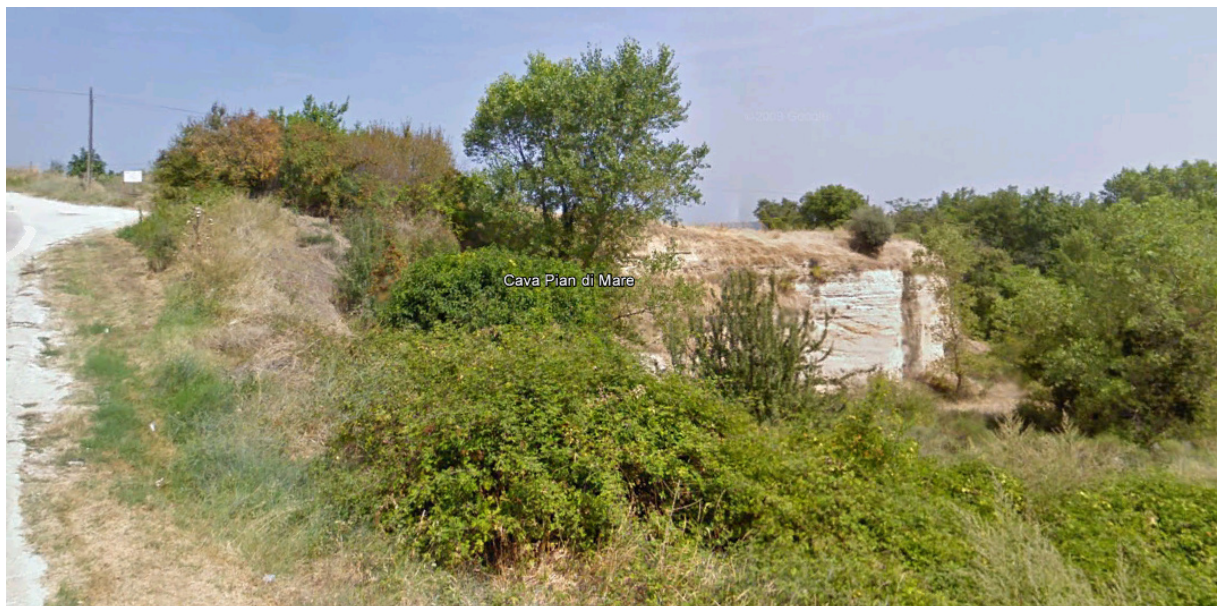
Foto 2 – Vista da Ovest. Punto di scatto dalla Strada Comunale Pian di Mare. Si vede la parte esterna, a Valle, della cava.
