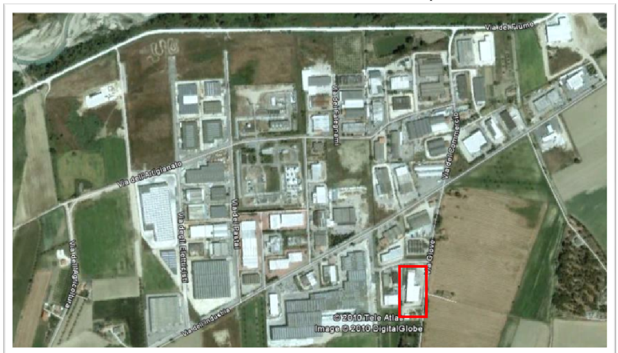
Zona industriale Scerne di Pineto - Sede dell’impianto
