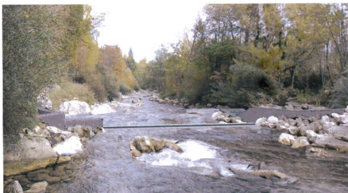
Figura 26: Rendering della traversa di captazione e opera di presa lato ovest.
