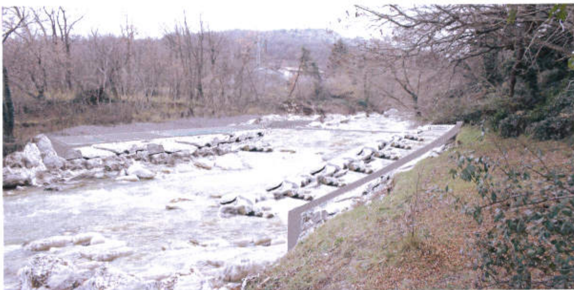
Figura 25: Rendering della traversa di captazione e opera di presa lato est.
