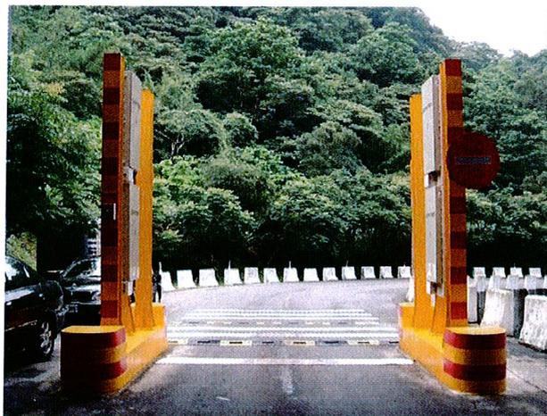
*Foto 1: Portale fisso SAF-3000 per la rilevazione di sorgenti radioattive*
