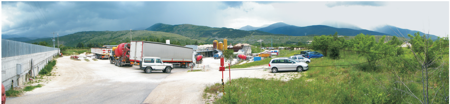
La foto documenta: l'impianto in piazzale a quota ribassata per minimizzare l'impatto dei silos, il rumore ecc, il raccordo smussato con la parte (lato dx) della cava in essere coltivata e ritombata lasciando un piazzale per esigenze di manovra
