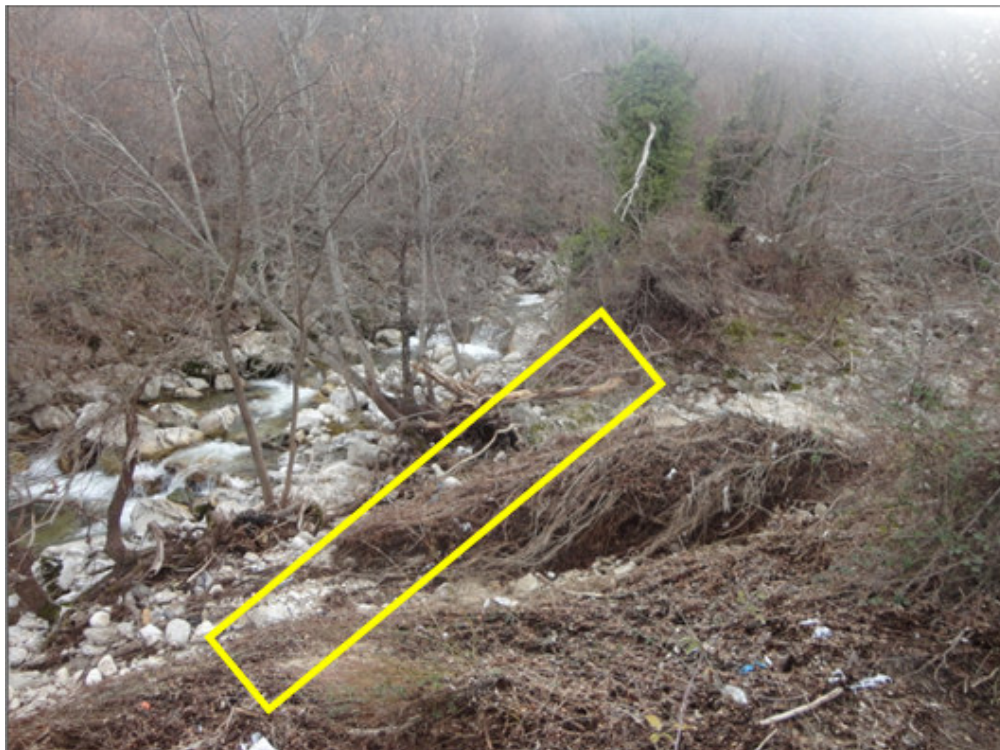
Foto 5- Area di ubicazione delle opere di protezione del manufatto dello scarico di restituzione
