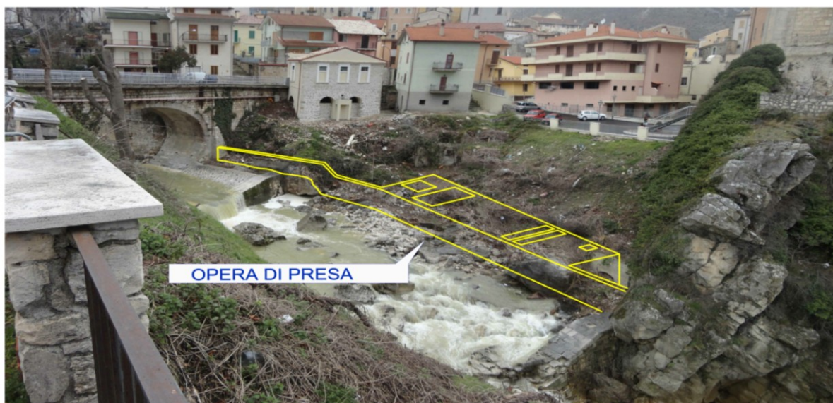
(Figura 3) – posizionamento dell'opera di presa in sponda sinistra
