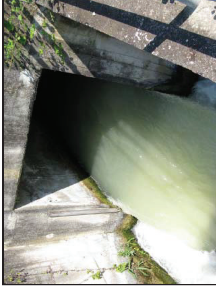
Figura 1.6: primo salto canale di scarico – ubicazione della paratoia d'intercettazione.
