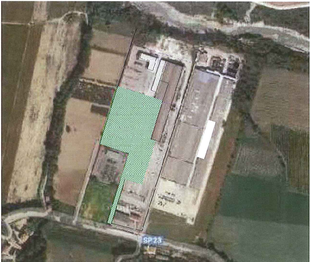
Area Impianto Ricompost sas
