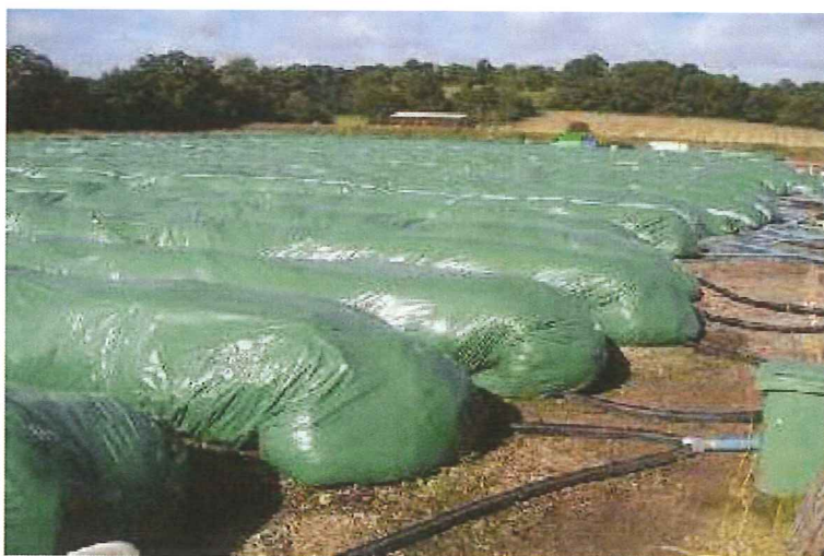
Foto n.4 – POD riempiti in lavorazione
