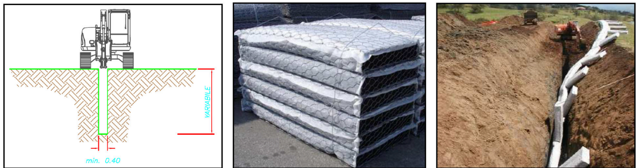
Fig.2: Modalità di posa in opera, realizzazione dello scavo a sezione obbligata (a sx), stoccaggio dei pannelli in cantiere (al centro) e inserimento dei pannelli preassemblati all'interno degli scavi (a dx).
