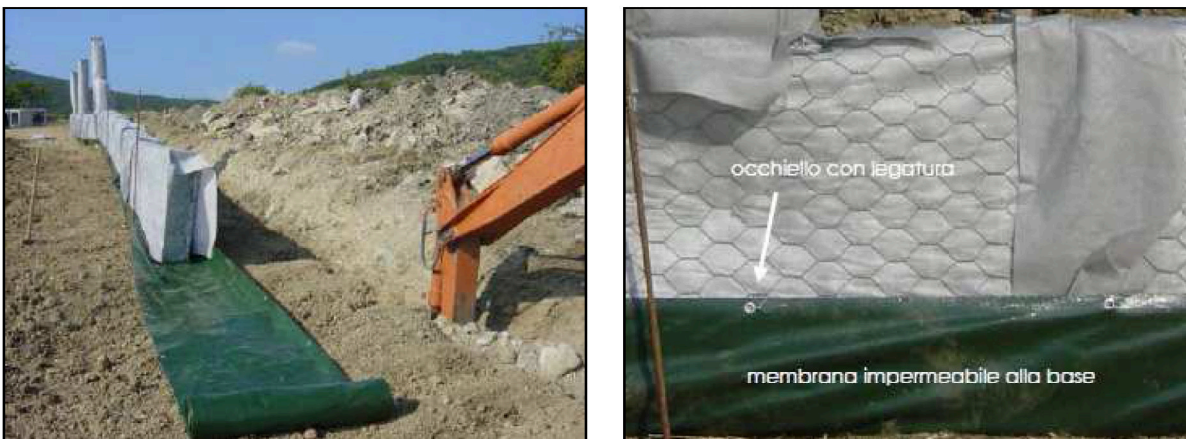
Fig.4: Posa in opera della guaina impermeabile di base (a sx) e relativo fissaggio (a dx).
