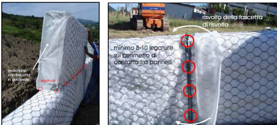
Fig.3: Assemblaggio tra le diverse file di pannelli sino ad altezza prestabilita (a sx) e tra i diversi pannelli (sotto a dx).
