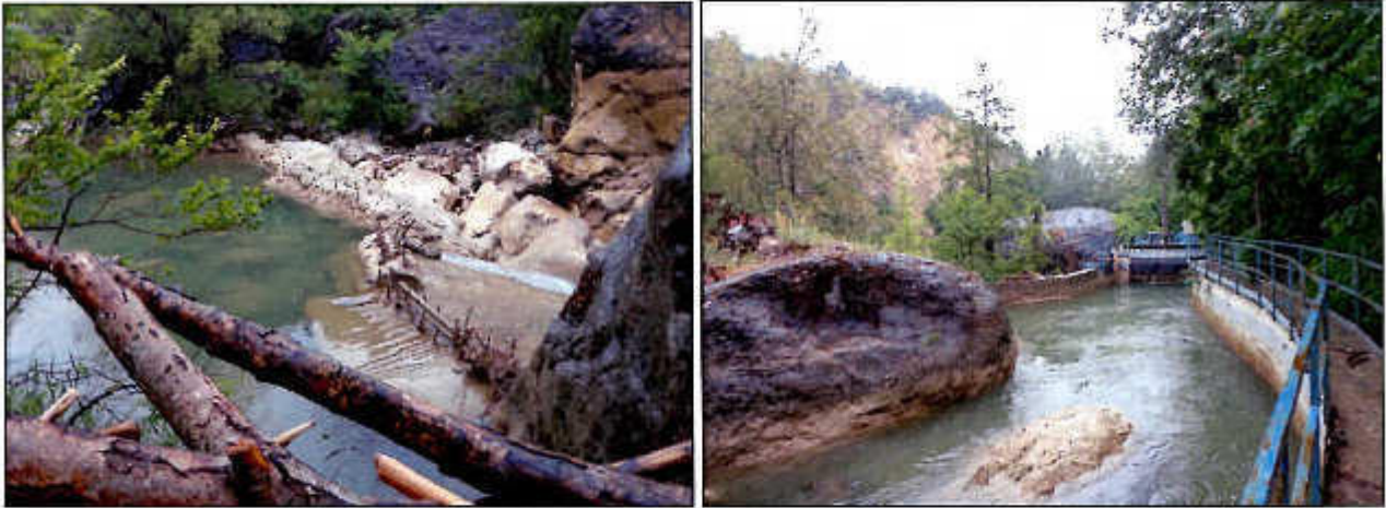
Foto 1 e 2. Traversa in pietra (sx) e vasca di carico con paratoia di carico con griglia (dx).
