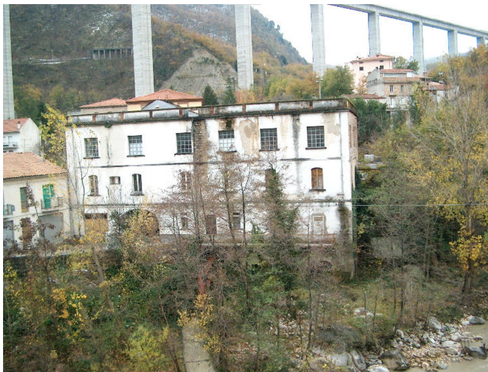
Fabbricato comunale con Centralina al Piano Seminterrato.
