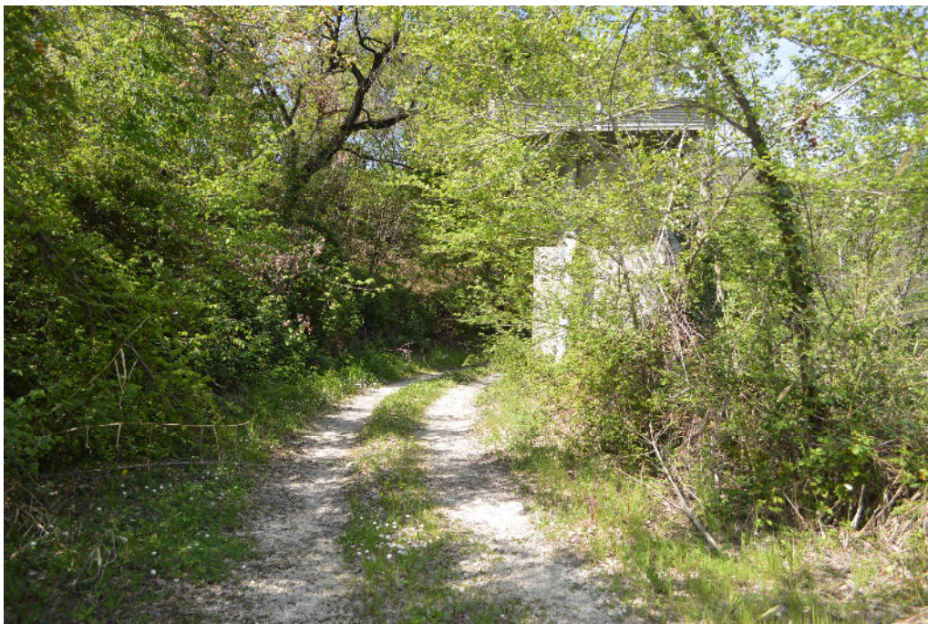
Strada di accesso all'opera di presa del Fiume Sangro con condotta interrata e Pozzo Piezometrico.
