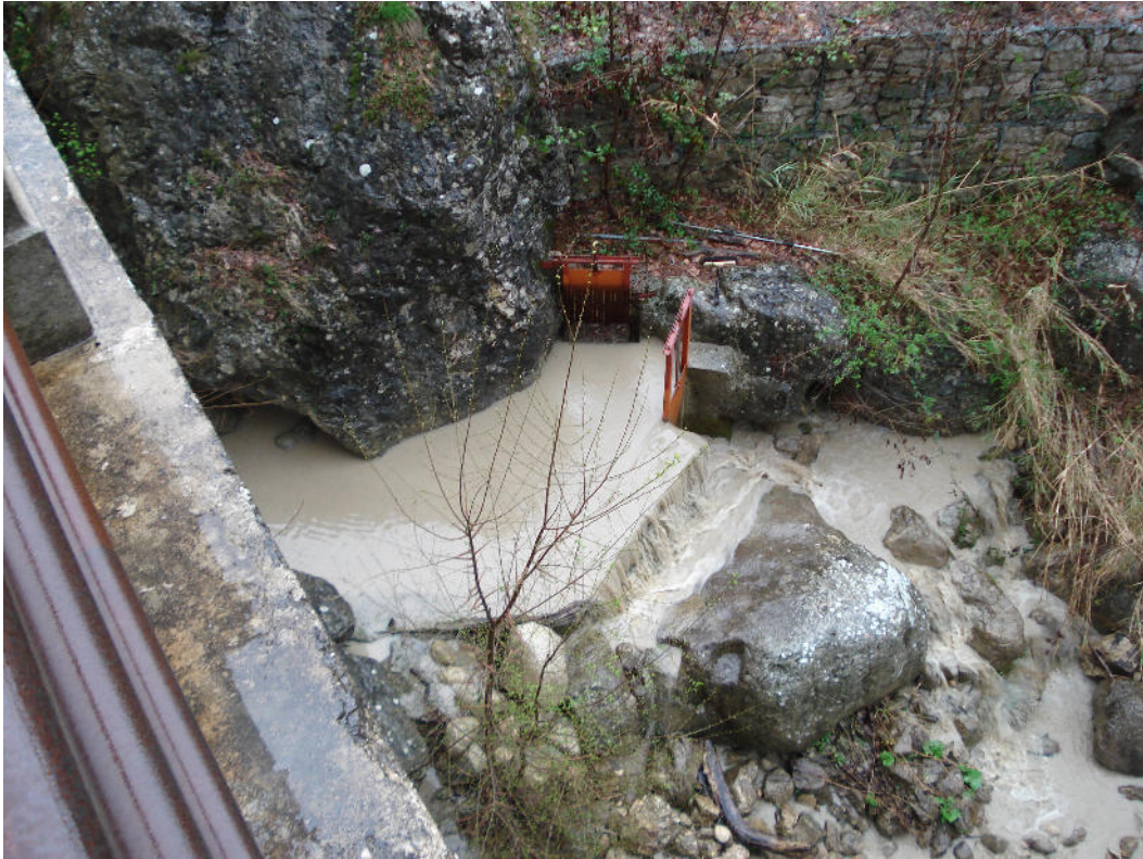
Traversa sul Torrente Turcano in periodo di piena, Opera preesistente.
