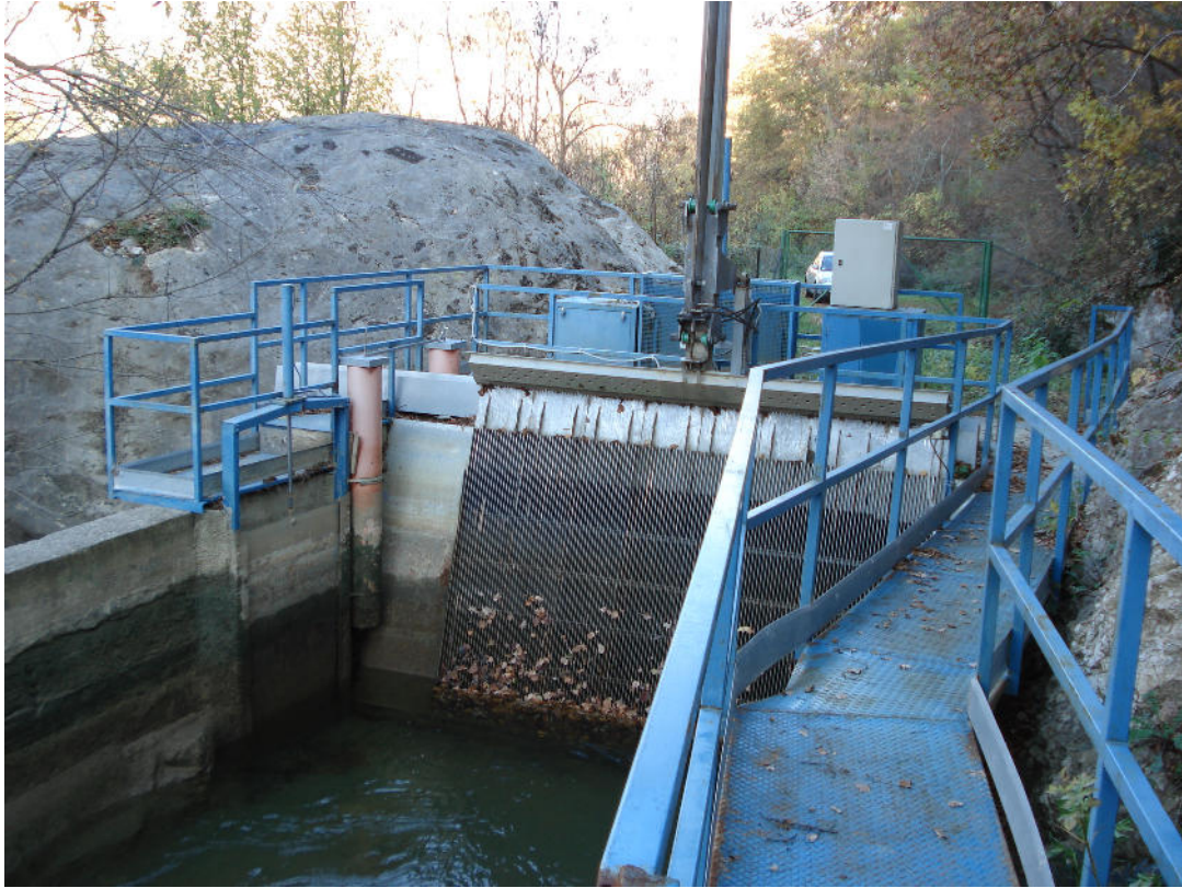
Invaso con sgrigliatore sul Fiume Sangro, nella vasca preesistente
