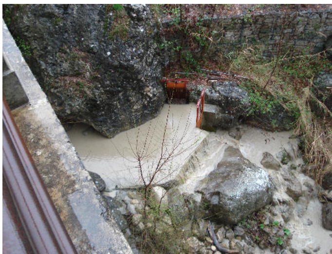
Vasca di carico sul Torrente Turcano.
