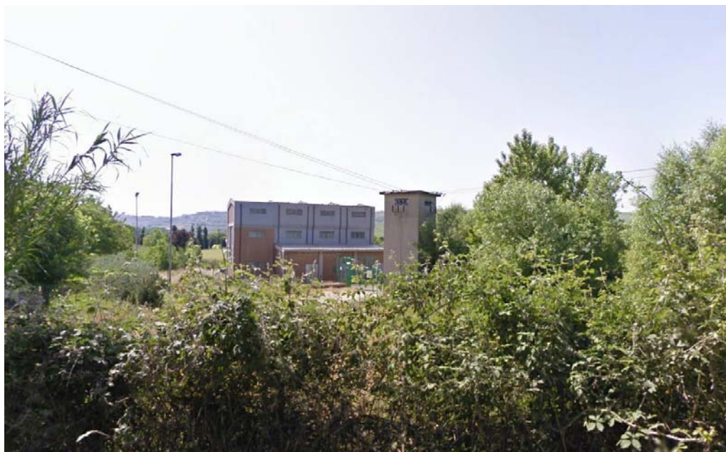
Figura 2: vista della centrale di S.Lucia
