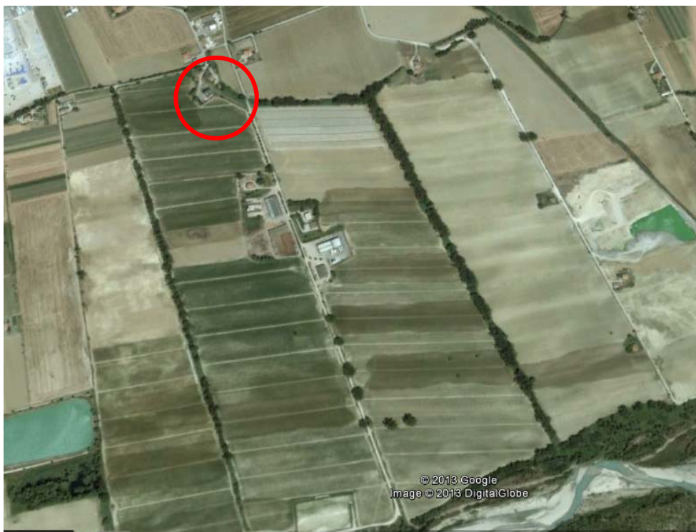
Figura 1: Vista Aerea della Zona di Intervento
