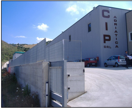
PIATTAFORMA A: particolare cancello d'ingresso e recinzione SETTORE 0a
