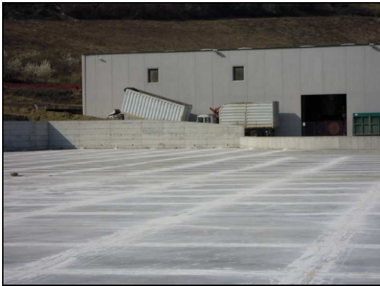
PIATTAFORMA B: Piazzale vista Sud-Ovest OPIFICIO "A"
