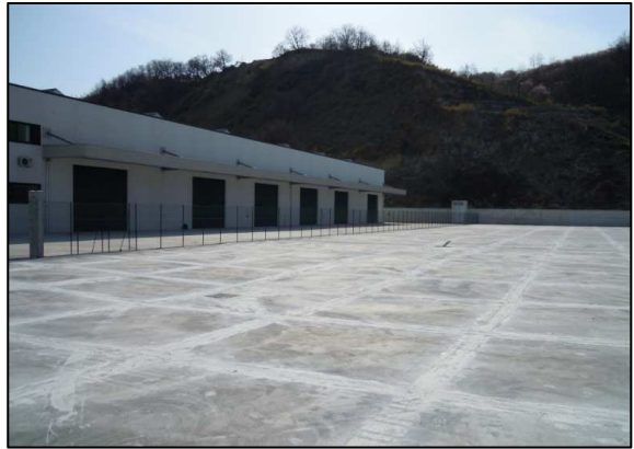
PIATTAFORMA B: Piazzale vista Est OPIFICIO "B"
