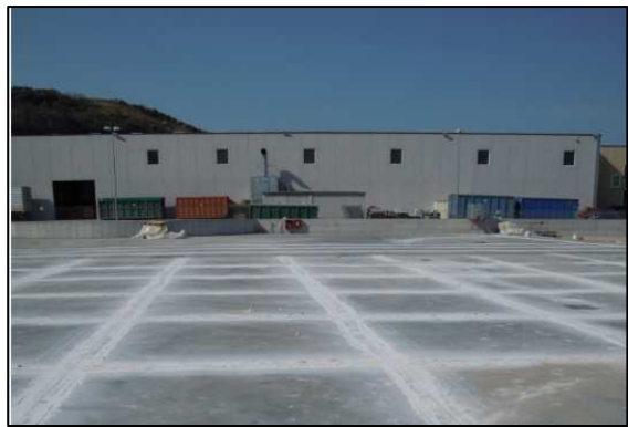
PIATTAFORMA B: Piazzale vista Sud-Ovest OPIFICIO "A"
