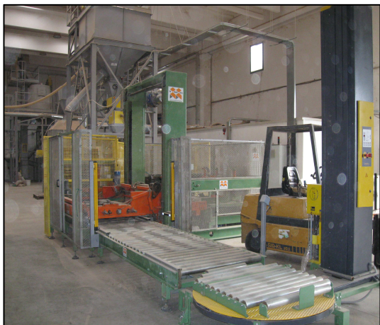
PIATTAFORMA A: Impianto di produzione pellets - SETTORE 9
