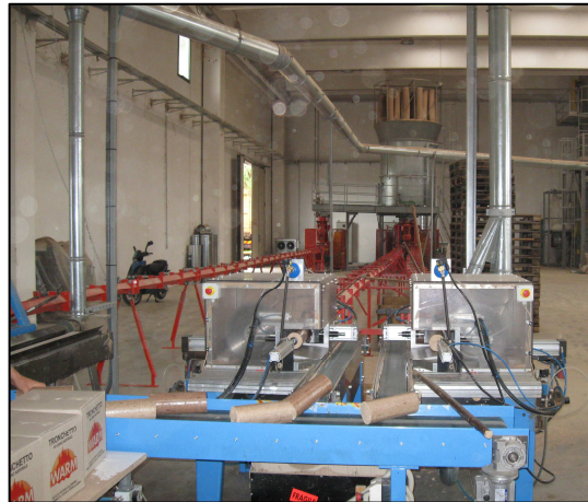
PIATTAFORMA A: Impianto di produzione tronchetti - SETTORE 9
