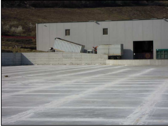
PIATTAFORMA B: Piazzale vista Sud-Ovest OPIFICIO "A"
