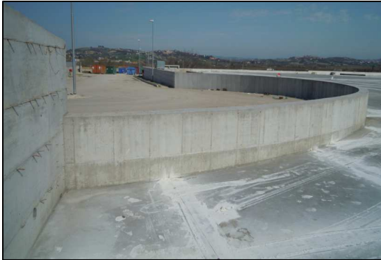
PIATTAFORMA B: Piazzale vista Nord
