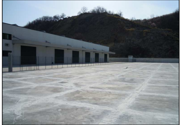
PIATTAFORMA B: Piazzale vista Est OPIFICIO "B"
