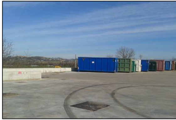
PIATTAFORMA B: Piazzale vista Nord
