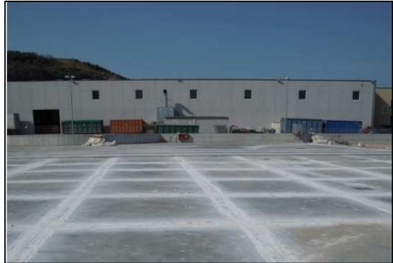
PIATTAFORMA B: Piazzale vista Sud-Ovest OPIFICIO "A"
